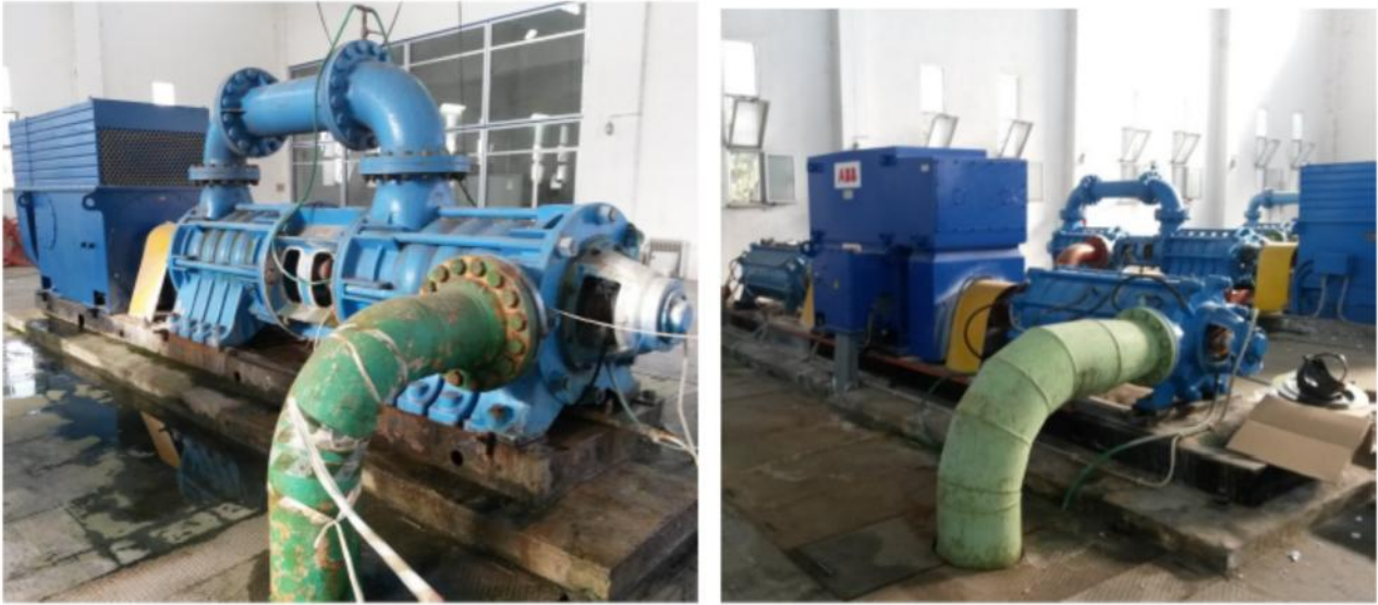
Fig. 2 Vista lati mandata e aspirazione elettropompa da 160 l/s e da 100 l/s ISI Pietrasasso
